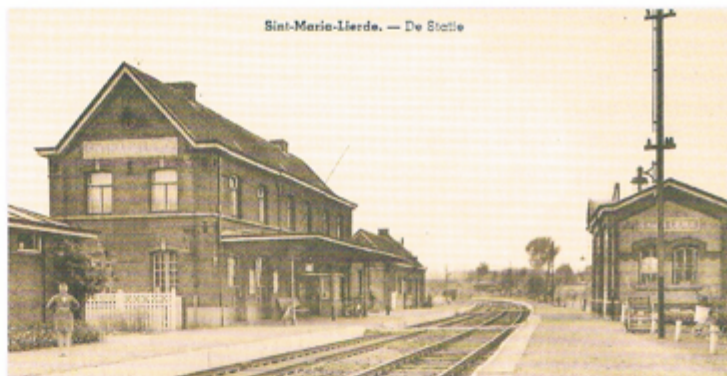
(ca 1950) Het gebouw lijkt nog weinig op het sierlijke en statige gebouw van vóór 1930, de mooie trapgevels zijn verdwenen. Onder de luifel is intussen een erker gebouwd zodat de (onder-)stationschef de aankomende of vertrekkende treinen kan waarnemen. Links op de voorgrond staat Antoine Verhelst.
